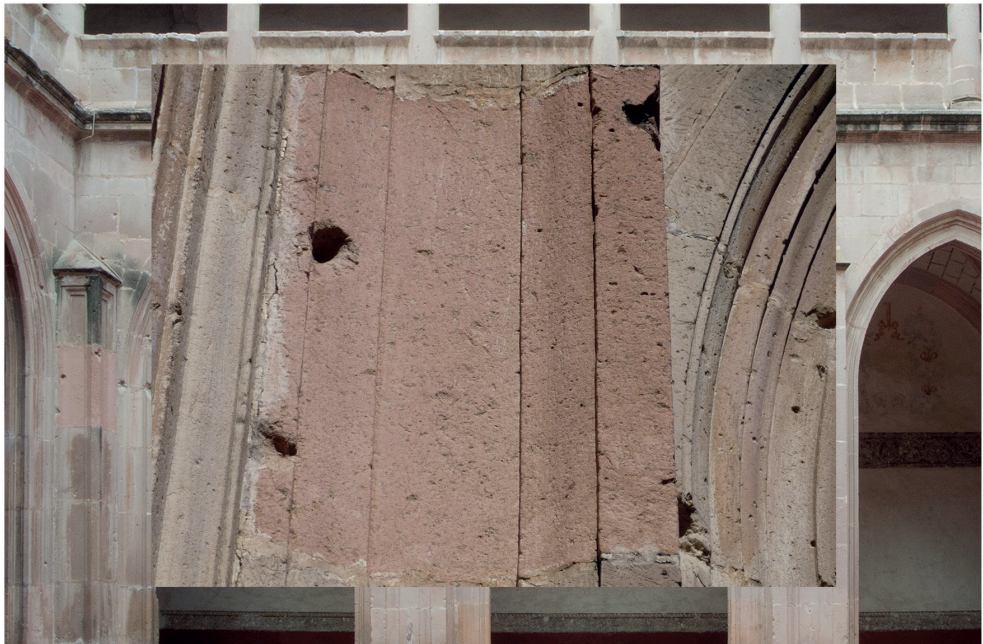
Lámina 11. Costado oriente del claustro bajo, detalle. Está marcado el contrafuerte de la esquina norte-oriental con el sillar que conforma al contrafuerte y que presenta un tono distinto, época contemporánea. Fotografía y edición de Juan Carlos Martínez Guzmán
